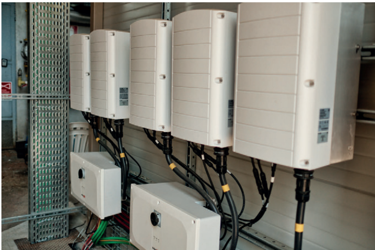
Inverter e centrale termica
