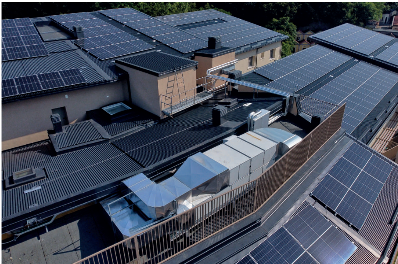
Visione dall'alto e copertura.
